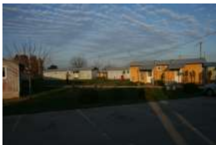
logements des pensionnaires à la maison de retraite de Ilock
