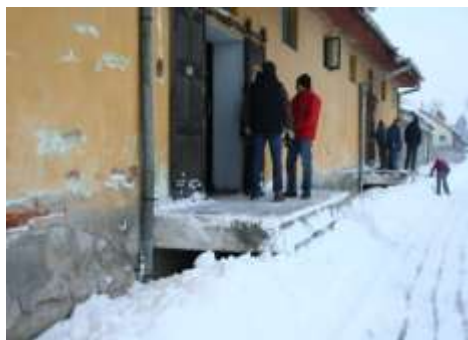
Le quai de déchargement
